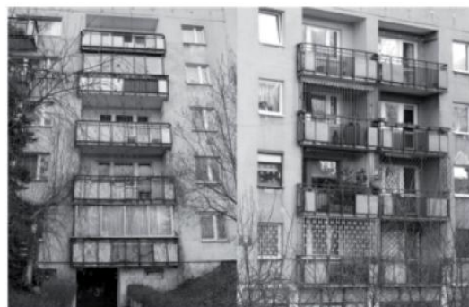
RYSUNEK 4. Przykłady zastosowania płyt płaskich prasowanych a-c w postaci ekranów balustrad balkonów w Warszawie przy ul. Stokłosy i ul. Zamiany FIGURE 4. Example of using flat and pressed plates of a-c in balcony railing screens in Warsaw at Stokłosy St. and Zamiany St.
